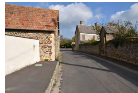
Etranglement en carrefour où la distance entre bâtis n'est pas sécuritaire.
